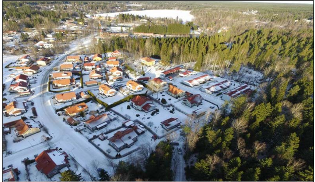
Kuva 2. Puukontie ilmasta katsottuna.
